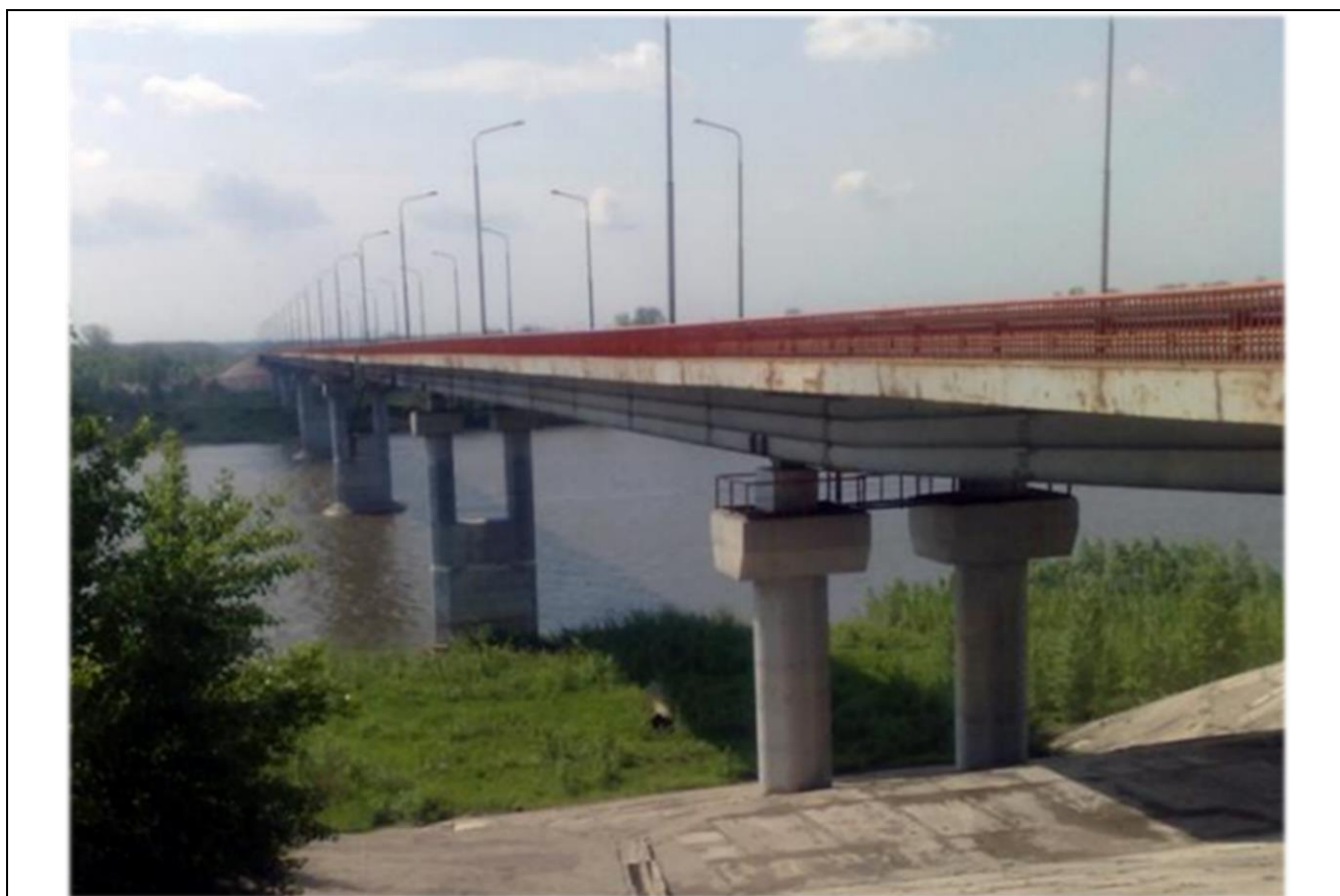
Рис. 1. Общий вид моста
