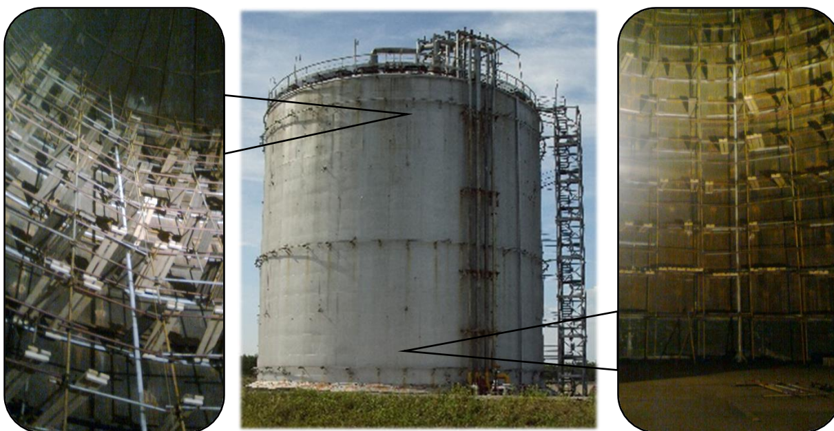
Рис. 2. Монтаж строительных лесов для проведения технического диагностирования внутренней металлической емкости изотермического резервуара.
