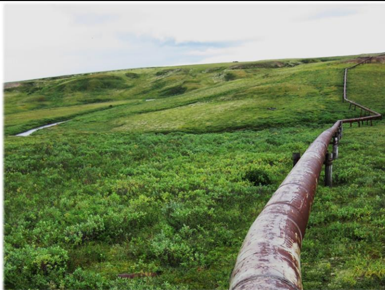
Рис. 1. Общий вид трубопровода
