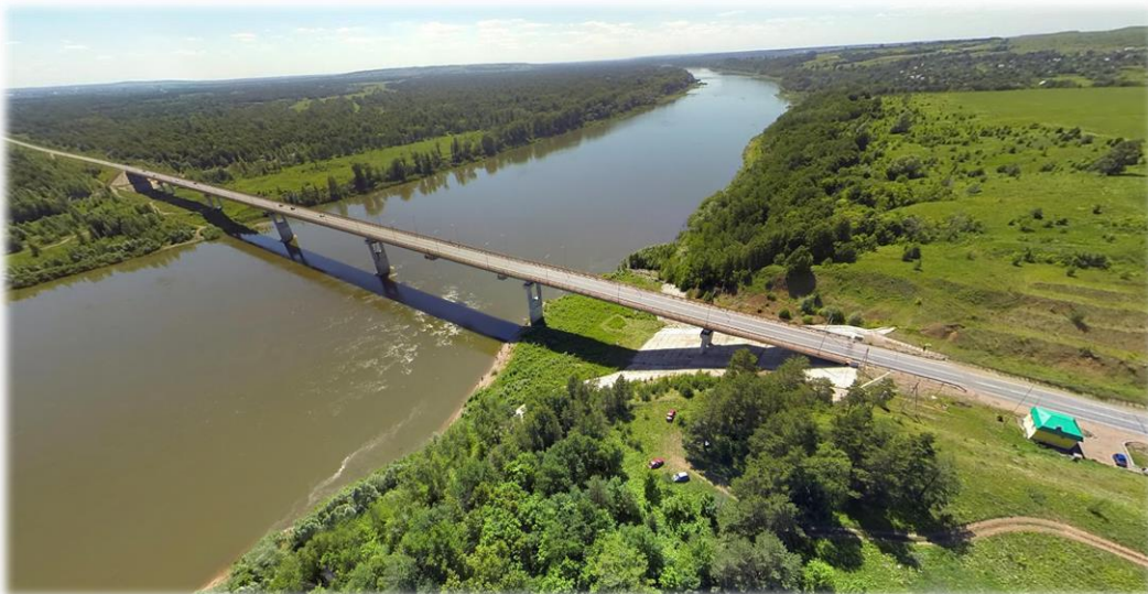
Рис. 1. Общий вид моста
